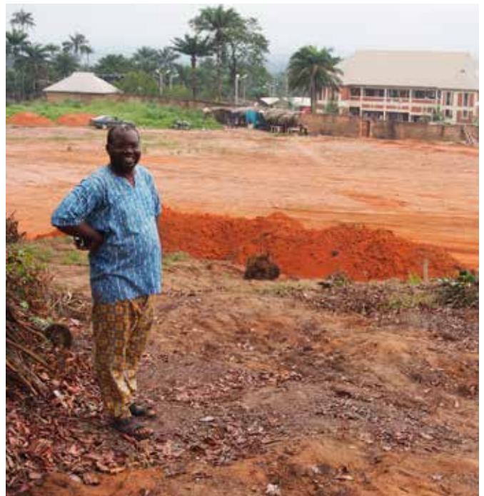
Ozioma Nwachukwu vor der Baustelle
